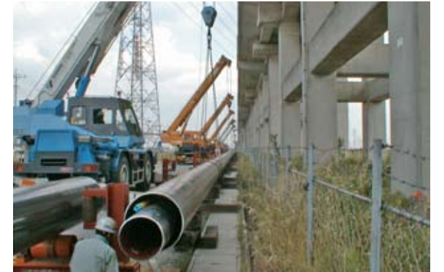
長尺管接続状況
