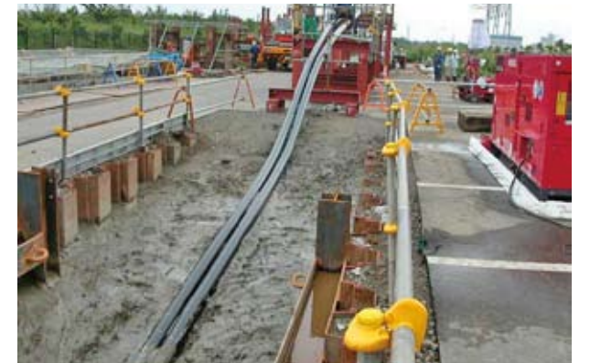
PE管引込状況
