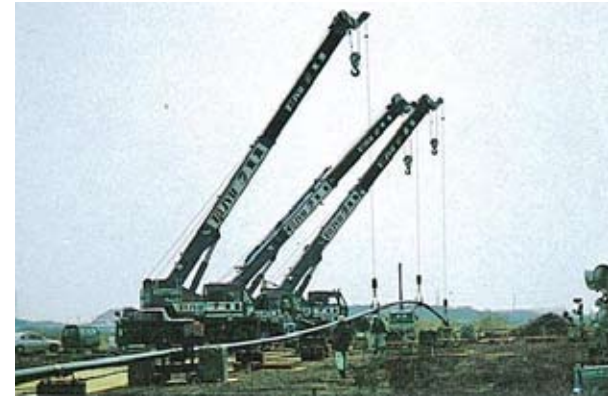
長尺管引込状況(ガス管)
