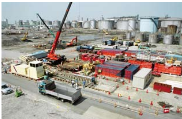
発進ヤード全景
