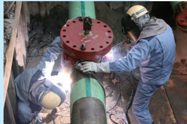
継手溶接(活管状態)
