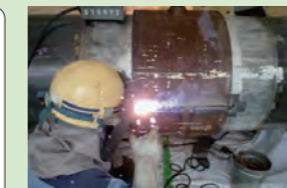
シーム溶接(ティグ+被覆アーク溶接)
