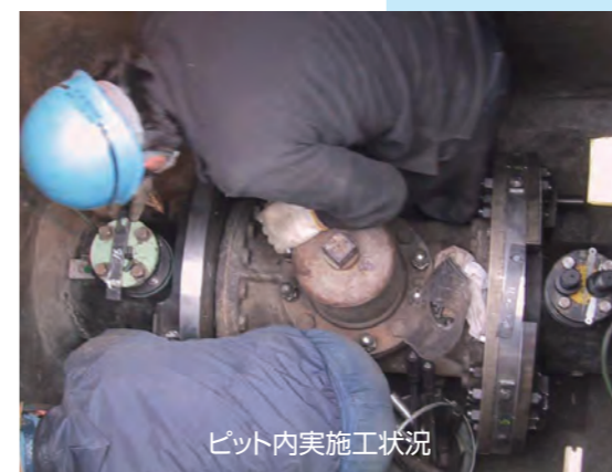
実施工状況例 (FCバルブ)
