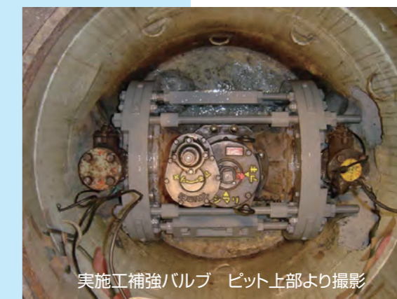
実施工状況例 (FCバルブ)
