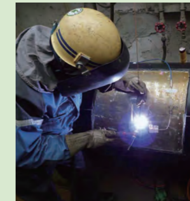
肉盛溶接 (ティグ溶接)
